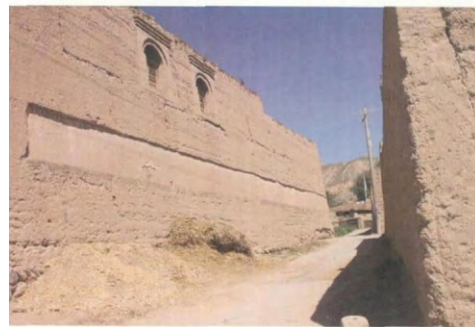
图02 庄廓院落墙的高窗
